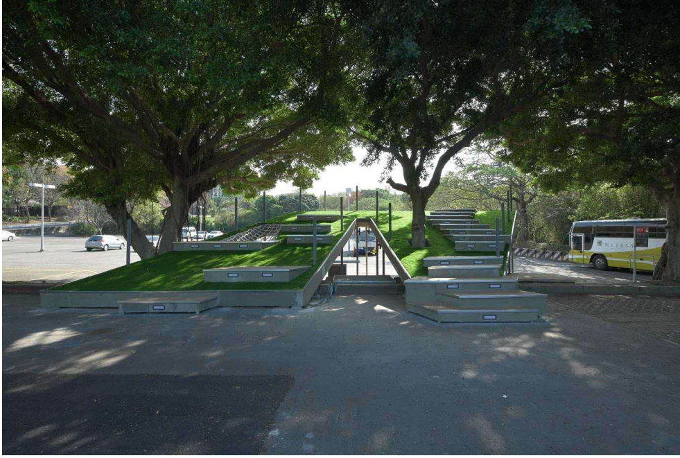
工程六館旁停車場候車亭工程成果照片
